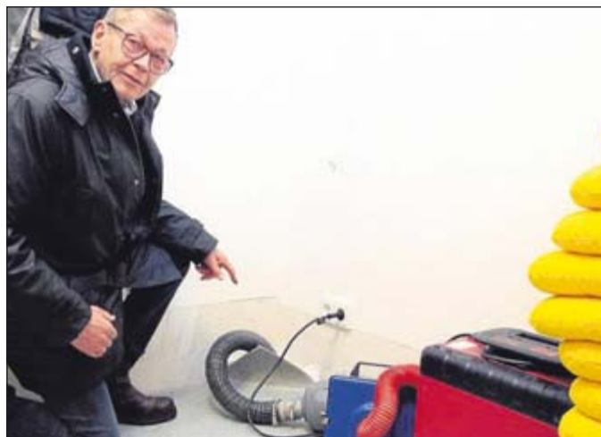
Im Kindergarten an der Jahnstraße, der erst seit Oktober geöffnet ist, gibt es einen Wasserschaden. Feuchte Stellen müssen jetzt getrocknet werden.
